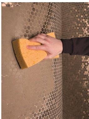
Utilizar una esponja húmeda para limpiar el material sobrante tras la colocación. Es importante no dejarlo secar. En caso de que el material se seque, utilizar desincrustantes para cemento o para pastas de rejuntar epoxy (no apto para piedra).
